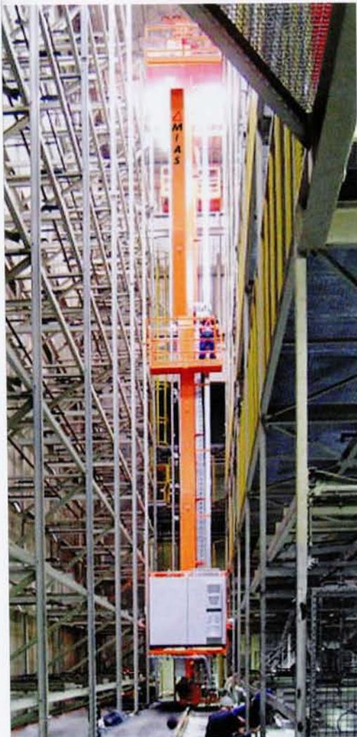
Der Mast eines neuen RBG wird durch die Dachöffnung in die Lagergasse eingehoben
